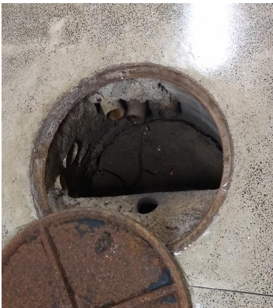
IMAGEM 2 – CAIXA DE ALVENARIA EXISTENTE DE ESGOTO SANITÁRIO.
